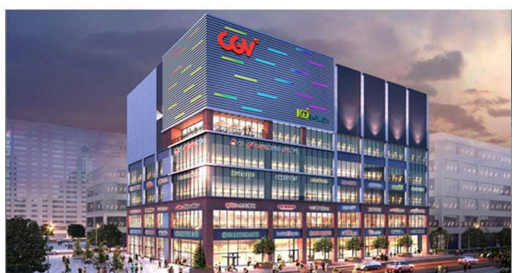
가수원 CGV 신축공사 중 냉각탑 공사 2019 2019.01.10 ~ 2019.03.25
