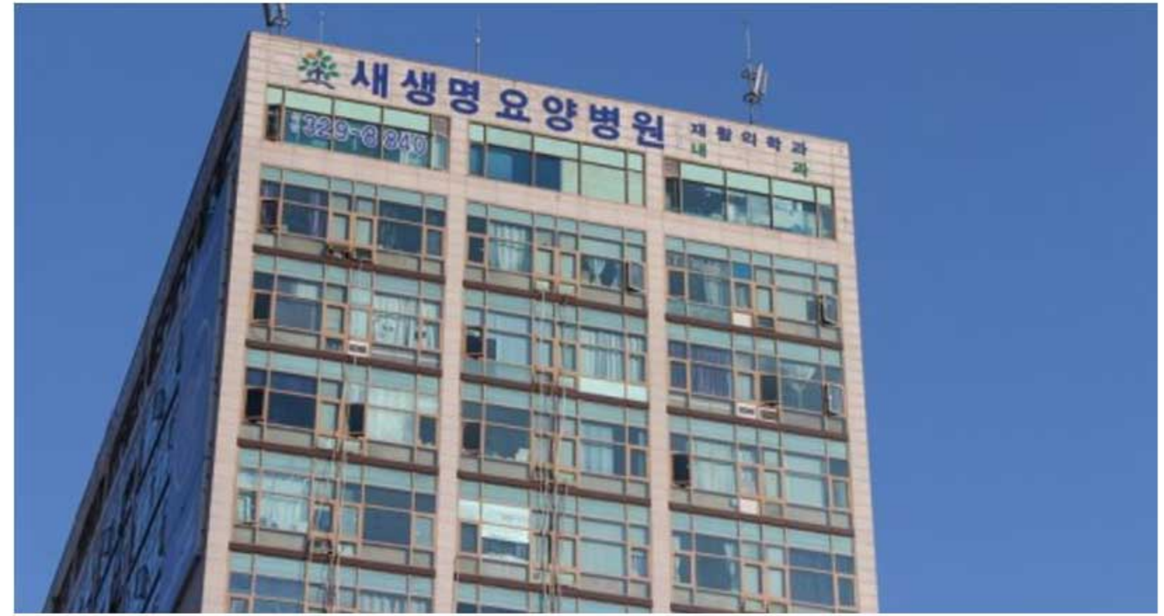
새생명 요양병원 냉난방공사 2017 2017.10.31 ~ 2018.02.28
