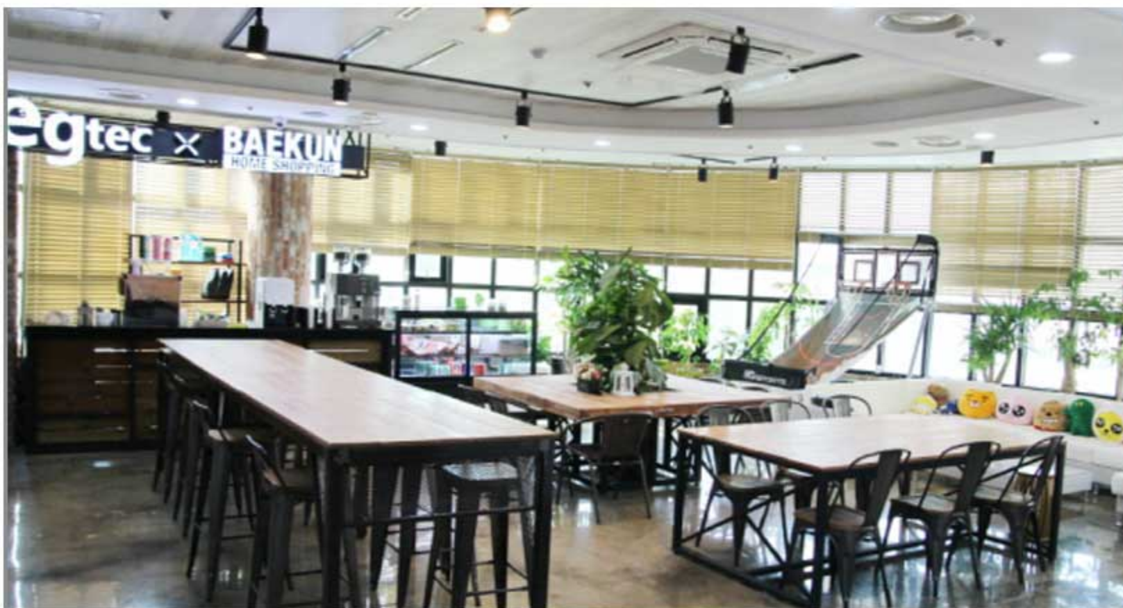
(주)이지텍 냉난방 설치 2017 2017.04.15 ~ 2017.04.27
