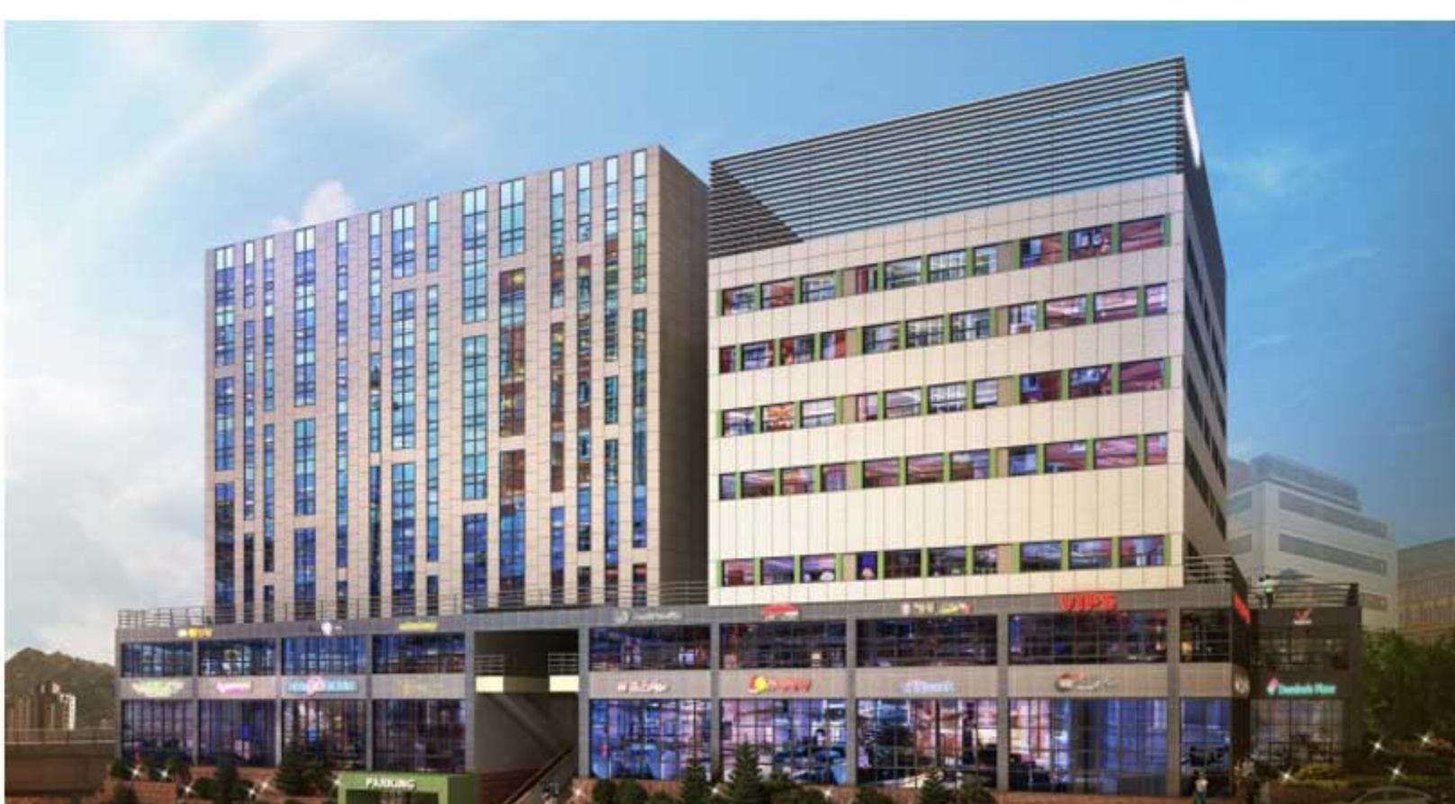
원주 H타워 신축공사 중 냉난방기 설치공사 2016 2016.06.06 ~ 2016.06.12
