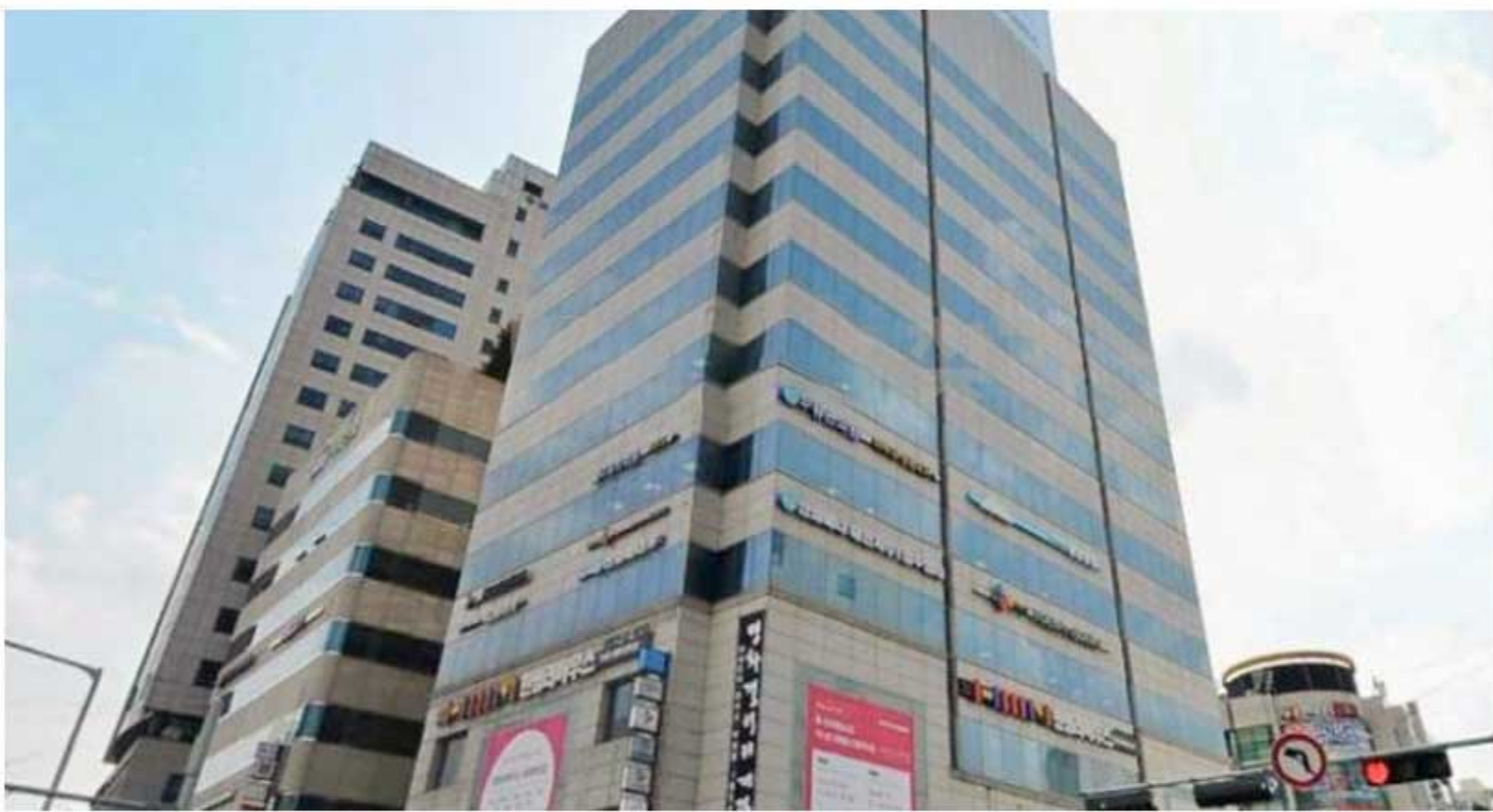
대전 영화빌딩 냉난방공사 2020 2020.10.01 ~ 2020.10.16
