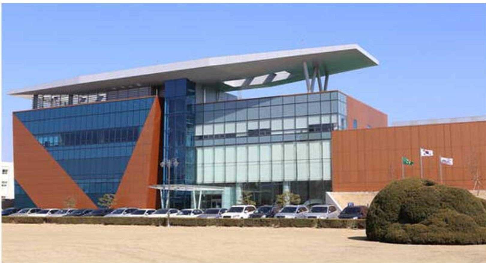
(주)케이티앤지 냉방기 공사 2020 2020.01.06 ~ 2020.02.28
