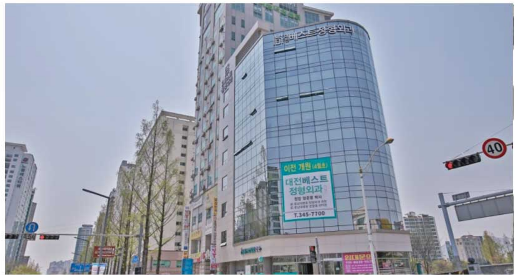
대전베스트정형외과병원 냉난방 공사 2020 2020.02.06 ~ 2020.04.29
