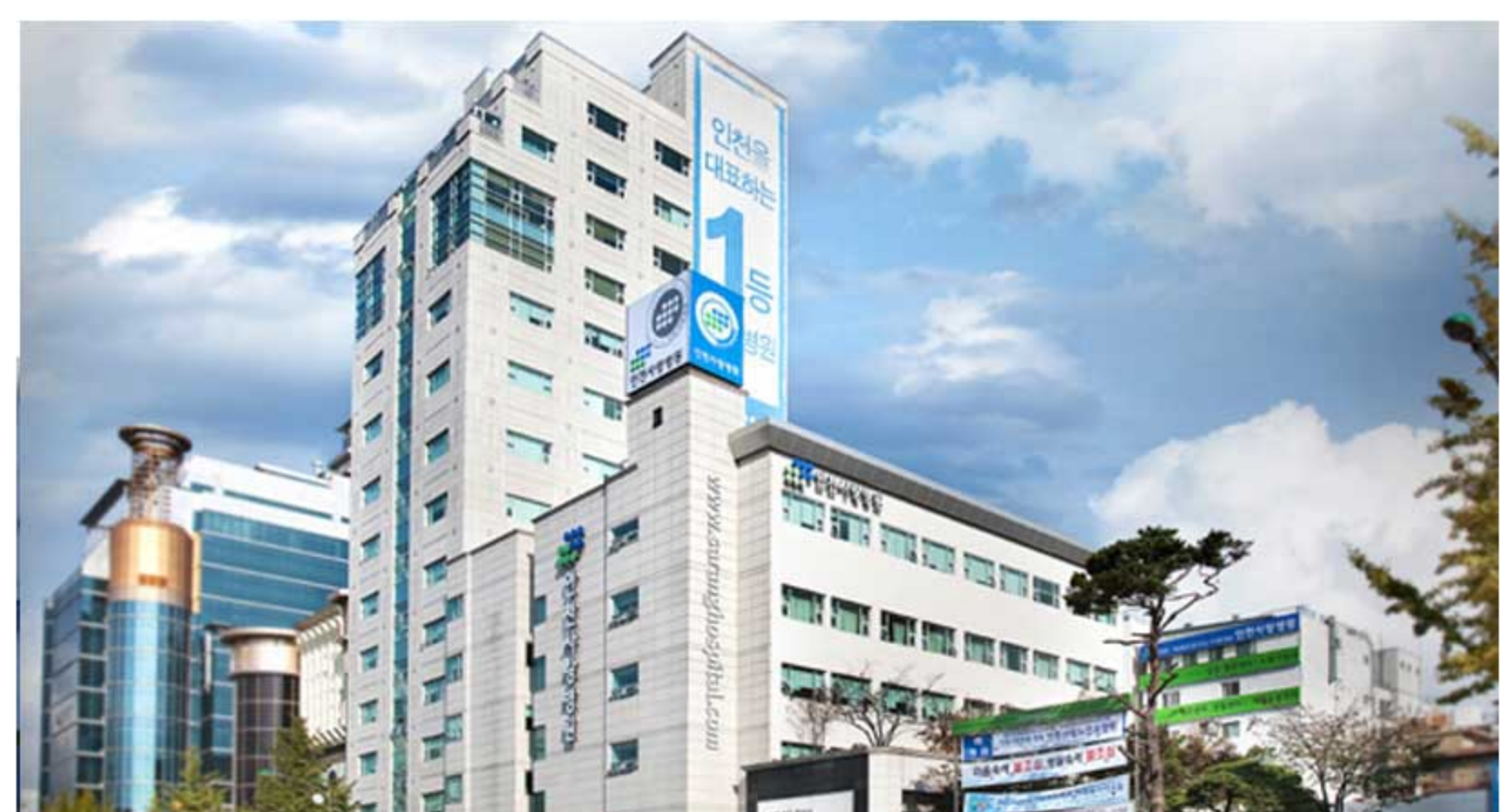
인천사랑병원 신축공사 중 별관 냉난방기 설치공사 2016 2016.06.04 ~ 2016.06.09
