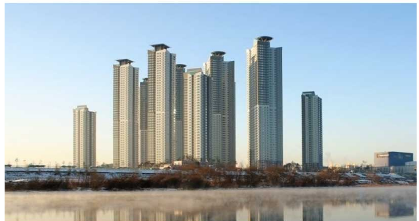
신탄진 엑슬루타워 신축공사 중 냉난방기 설치공사 2016.12.04 ~ 2017.12.29
