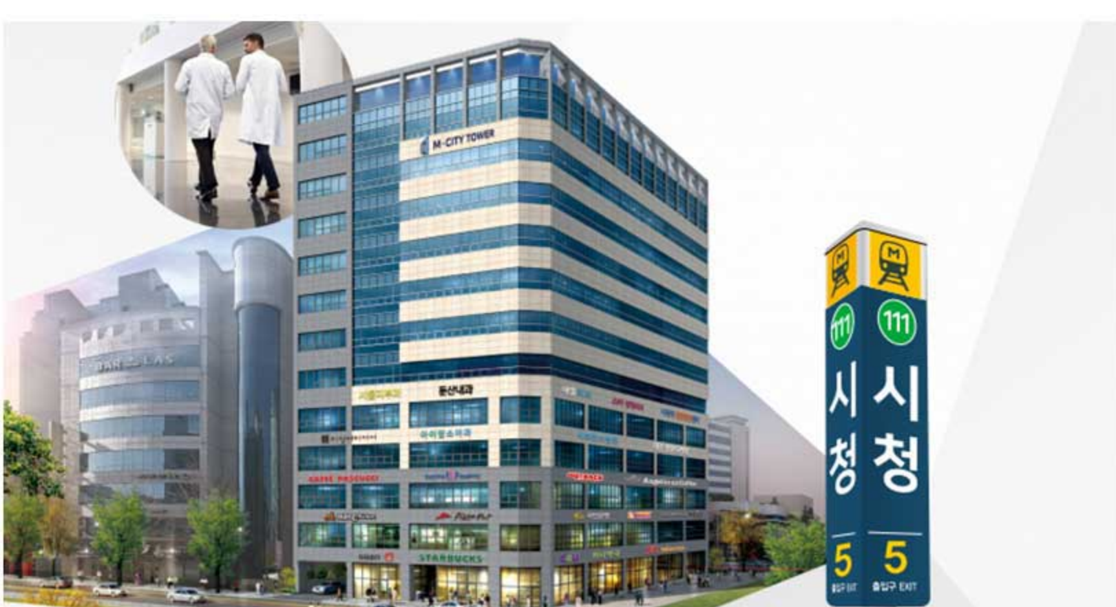
대전 M-CITY 타워 냉난방공사 2020 2020.12.05 ~ 2021.06.20
